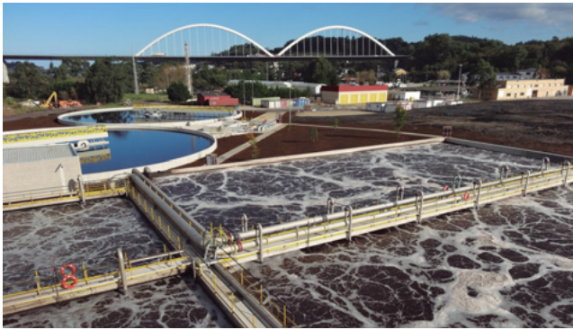
Foto: Veolia. Vista general de una planta de depuración biológica con lecho móvil (MBBR).
