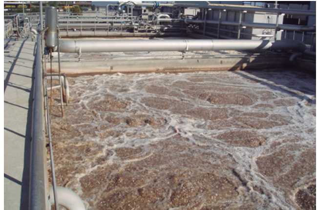
Foto: Veolia. Estación depuradora.
